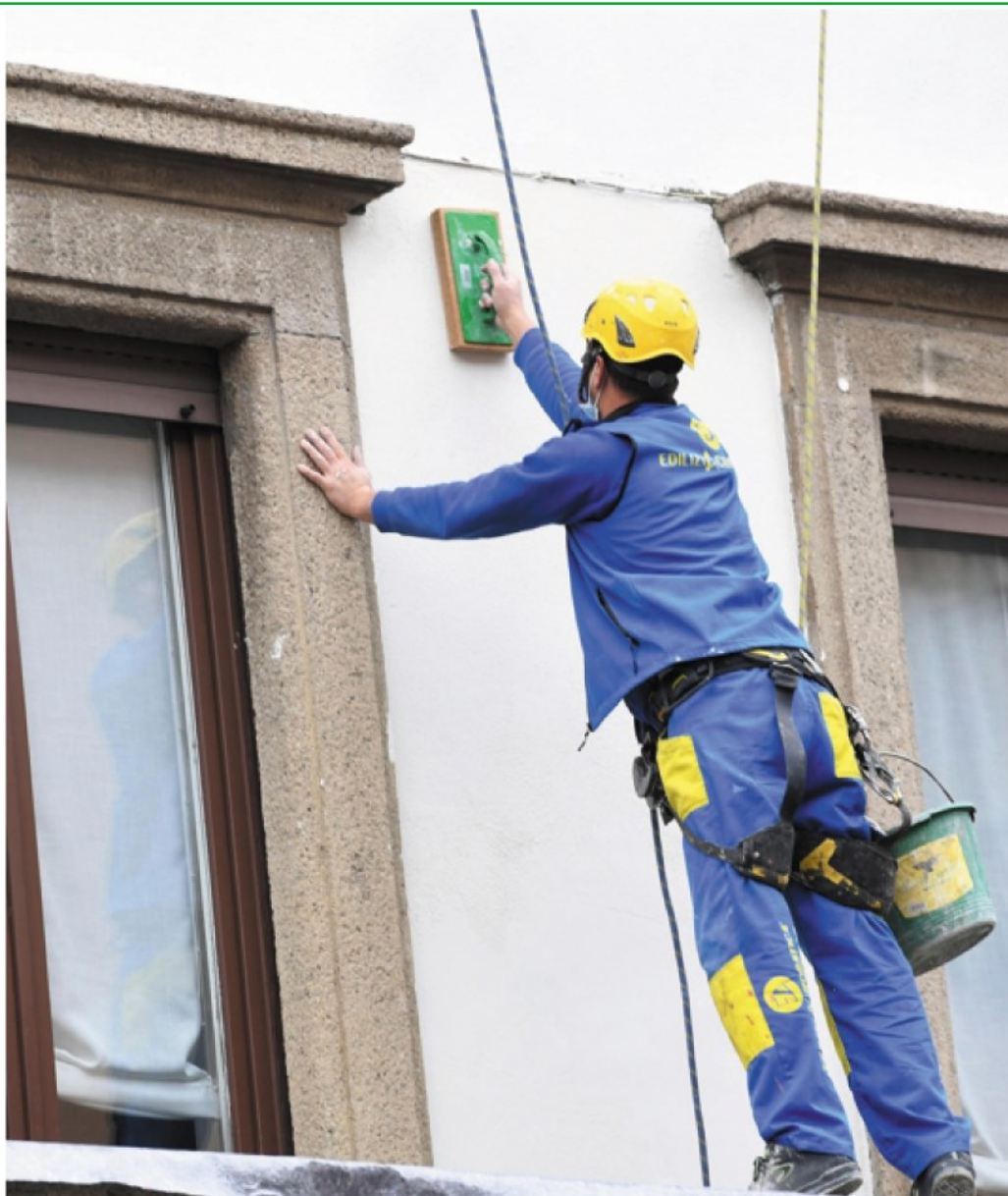
Un operaio lavora alla facciata di un palazzo di Milano ANSA
